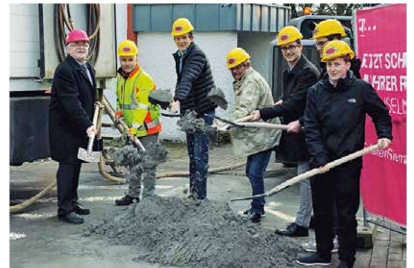
Spatenstich mit Bürgermeister Aumann für Glasfaserausbau Foto: Telekom
