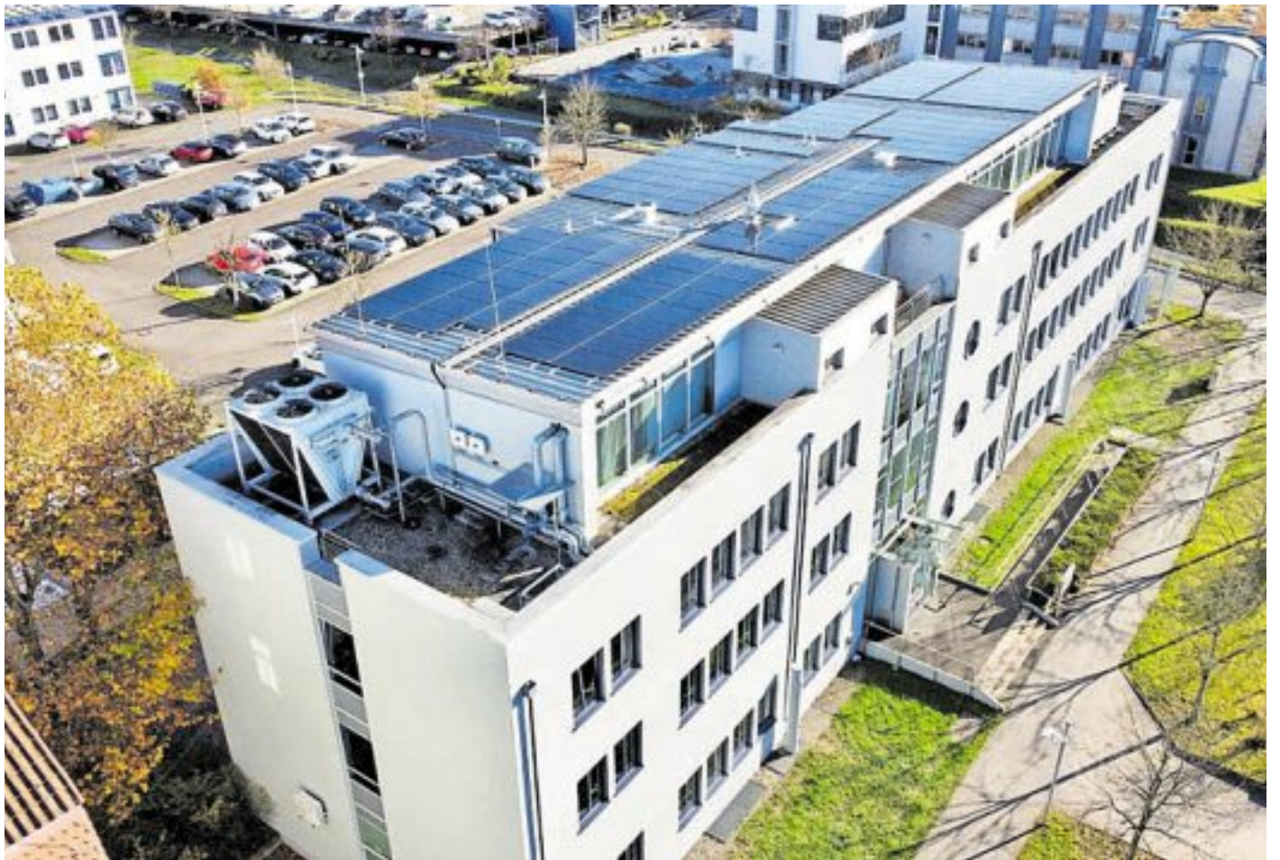
Beitrag zur Senkung der CO 2 -Emissionen: Die Photovoltaikanlage auf dem Dach des IKS-Betriebsgebäudes in der Nell-Breuning-Allee 1.
