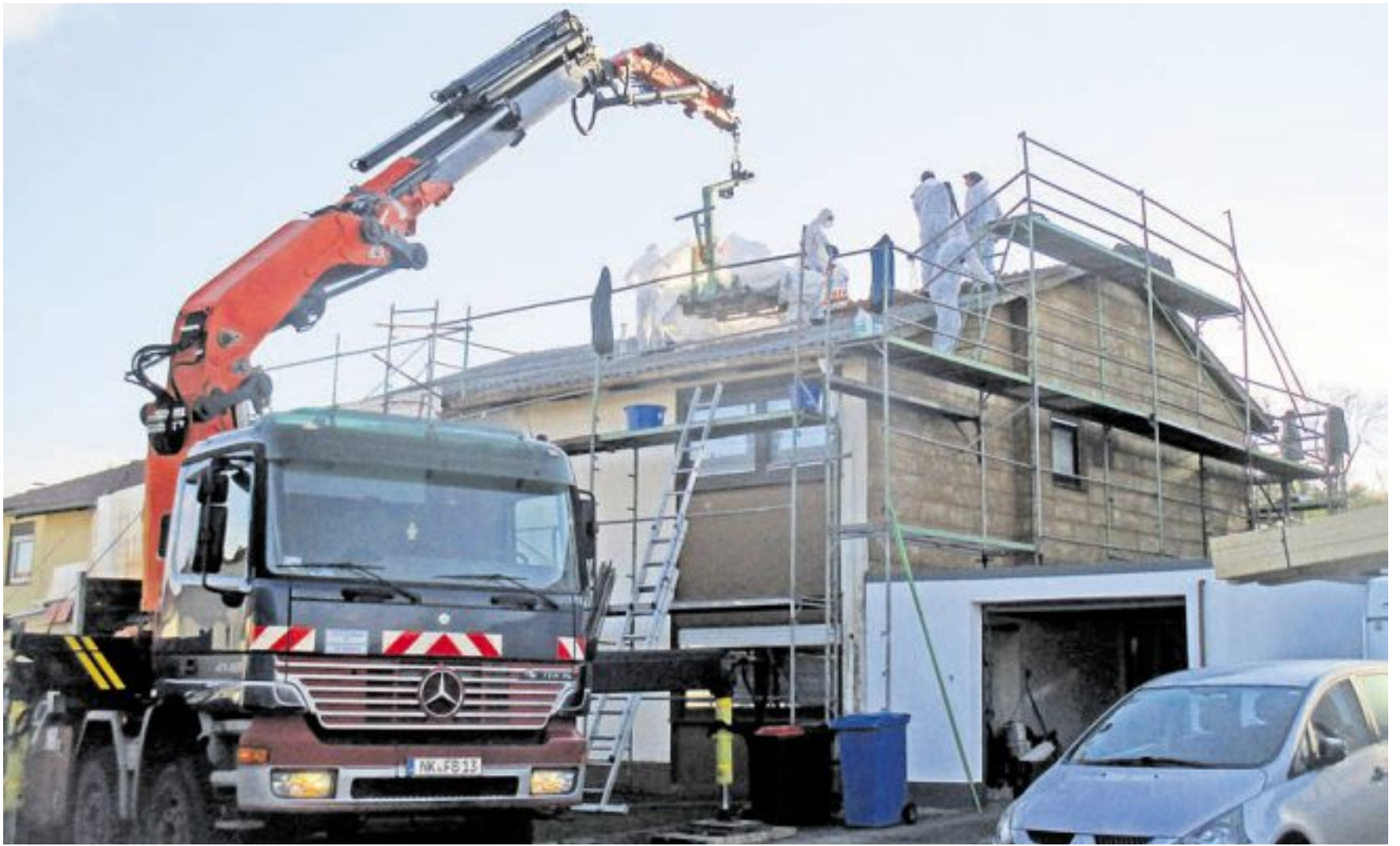
Die Wilfried Bach GmbH legt Wert auf die vorschriftsmäßige Demontage und Entsorgung des asbesthaltigen Dachmaterials.
