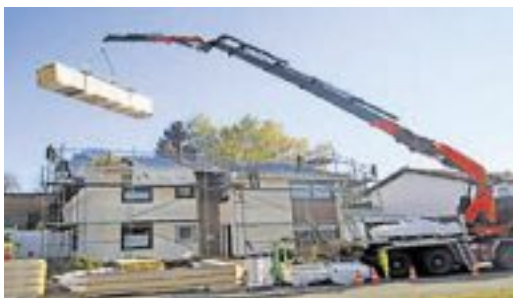
Fachgerecht werden anschließend die Sandwich-Elemente verlegt. Fotos: Bach
